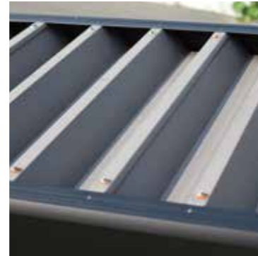
屋根材 ガルバリウム鋼板折板
