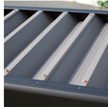
屋根材 ガルバリウム鋼板折板
