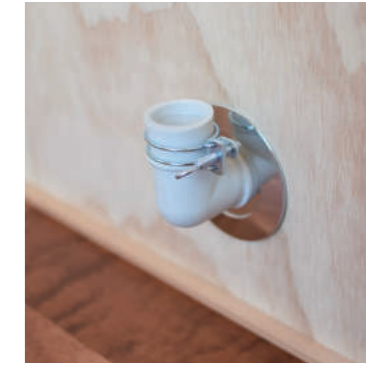
洗濯機用排水口
